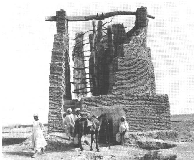
Abb. 1: Vertikalachsen-Windmühle [17, S.2]
