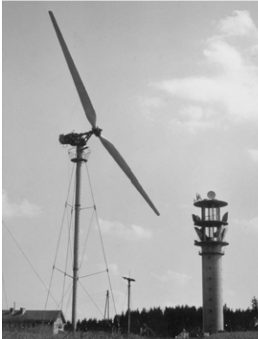
Abbildung 1-11: W34-Anlage, BRD, 1958 [16]
