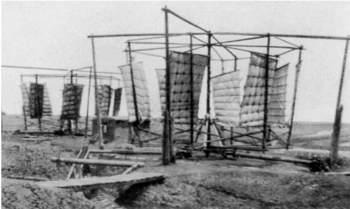
Abbildung 1-2: Chinesisches Windrad mit umklappbaren Flügeln [16]
