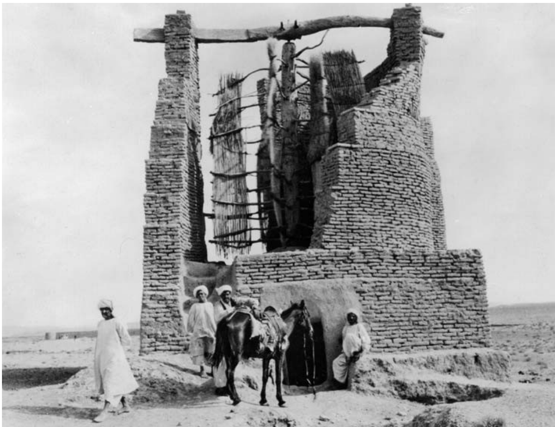
Abbildung 1-1: Windmühle mit vertikaler Drehachse in Afghanistan [16]
