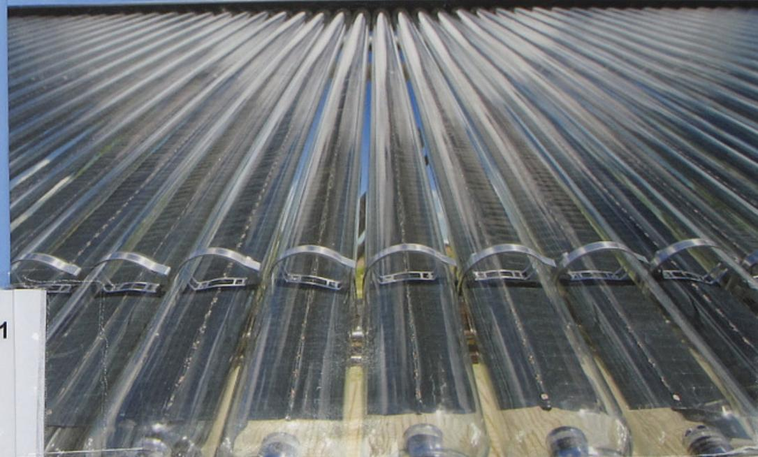
**BILD** Drain-Back-System im Betrieb (oben) und bei ausgeschalteter Pumpe (unten). Bei ausgeschalteter Pumpe entleert sich der Kollektor zum Schutz vor Frostschäden.
