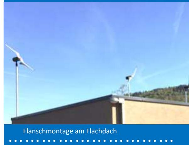
Flanschmontage am Flachdach
