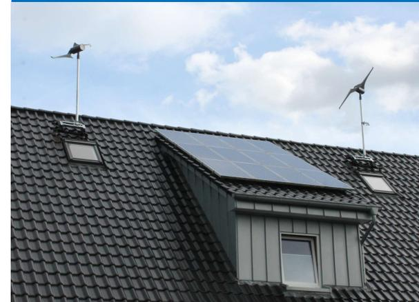
Entkoppelte Aufdachmontage auf Solarschiene (vgl. S. 24)
